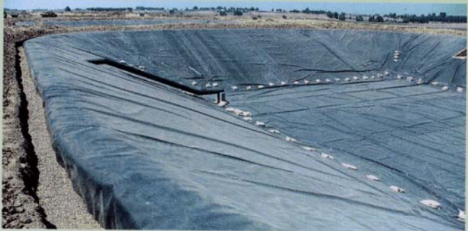
Pose de la géomembrane pour l'étanchéité des bassins aérés
