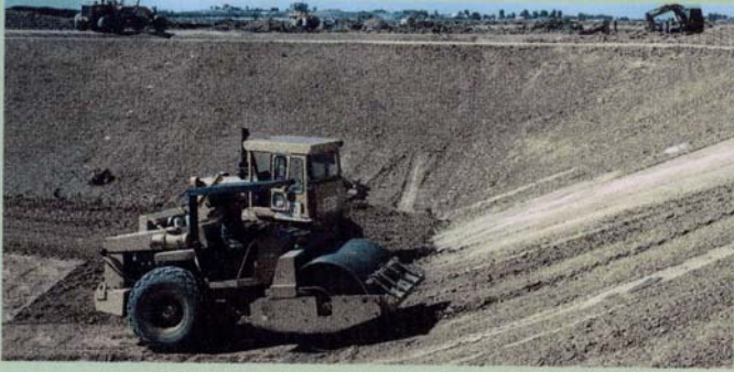
Bassin anaérobie en cours de compactage
