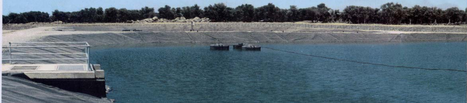
Bassin aéré étanché par géomembrane
